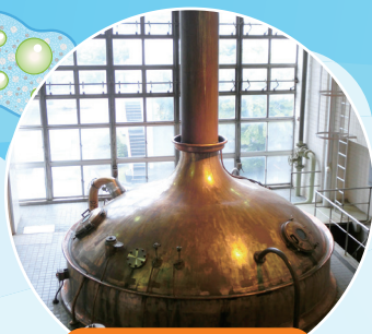
麒麟ビール 取手工場
